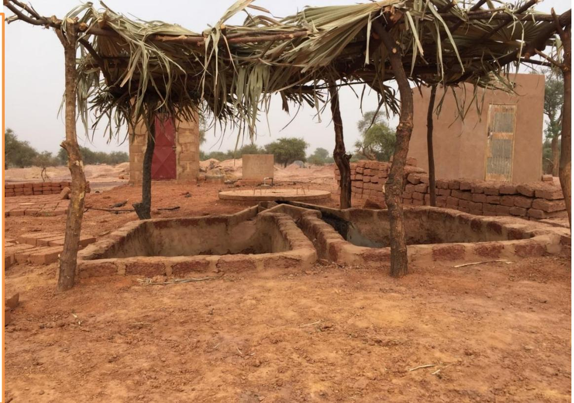
**Vue d'ensemble d'un biodigesteur modèle FASO BIO 15 connecté à la latrine**
